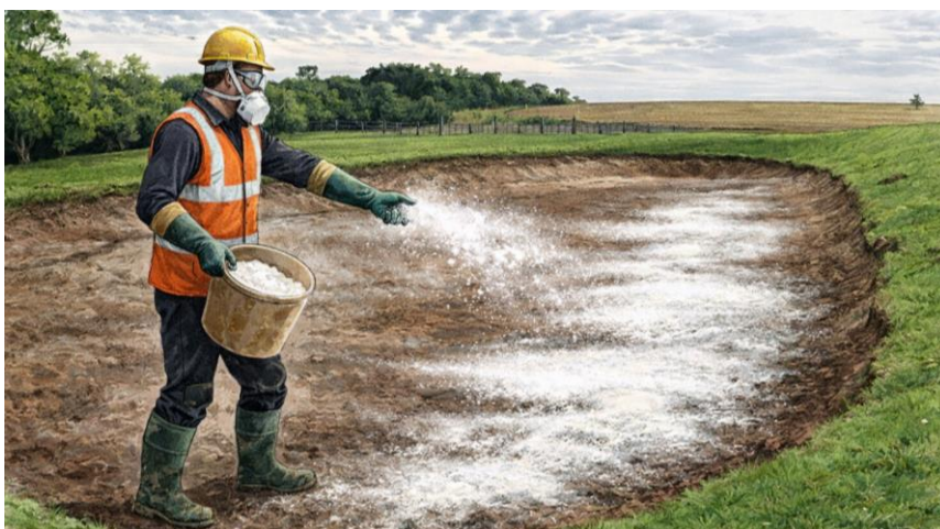
Figura 42. Desinfecção do tanque escavado com uso de EPI's.
